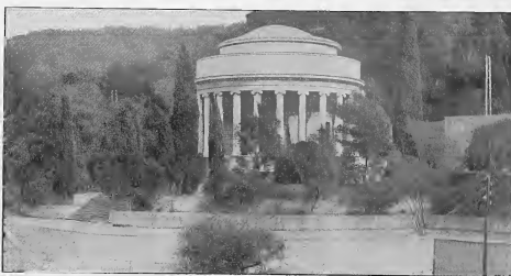
La chapelle de l'hôpital Saint-Mandrier
